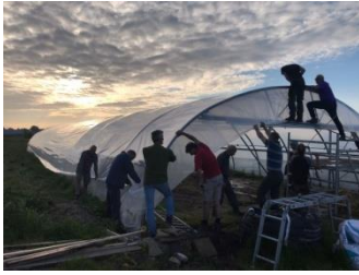
Foto Omslag: Dakfolie van de tunnelkas spannen
